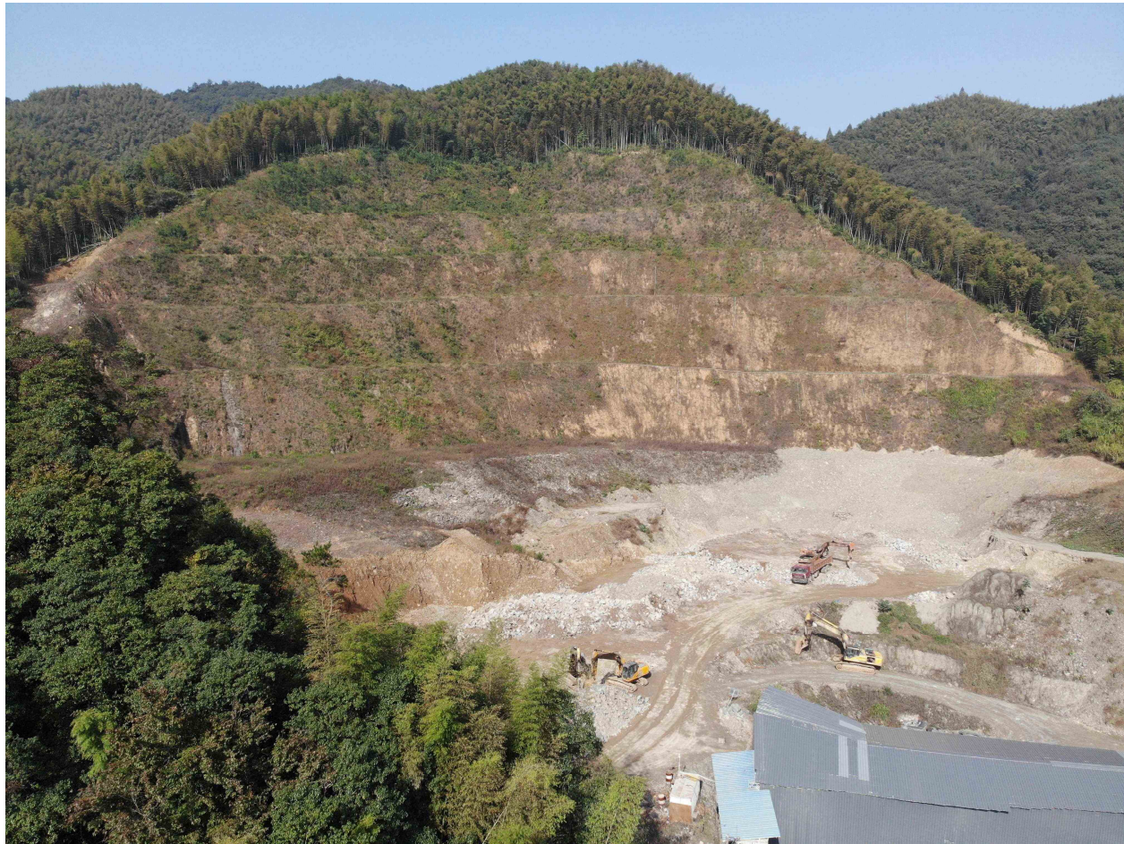
照片 2-3 AB、BC 段边坡现状
