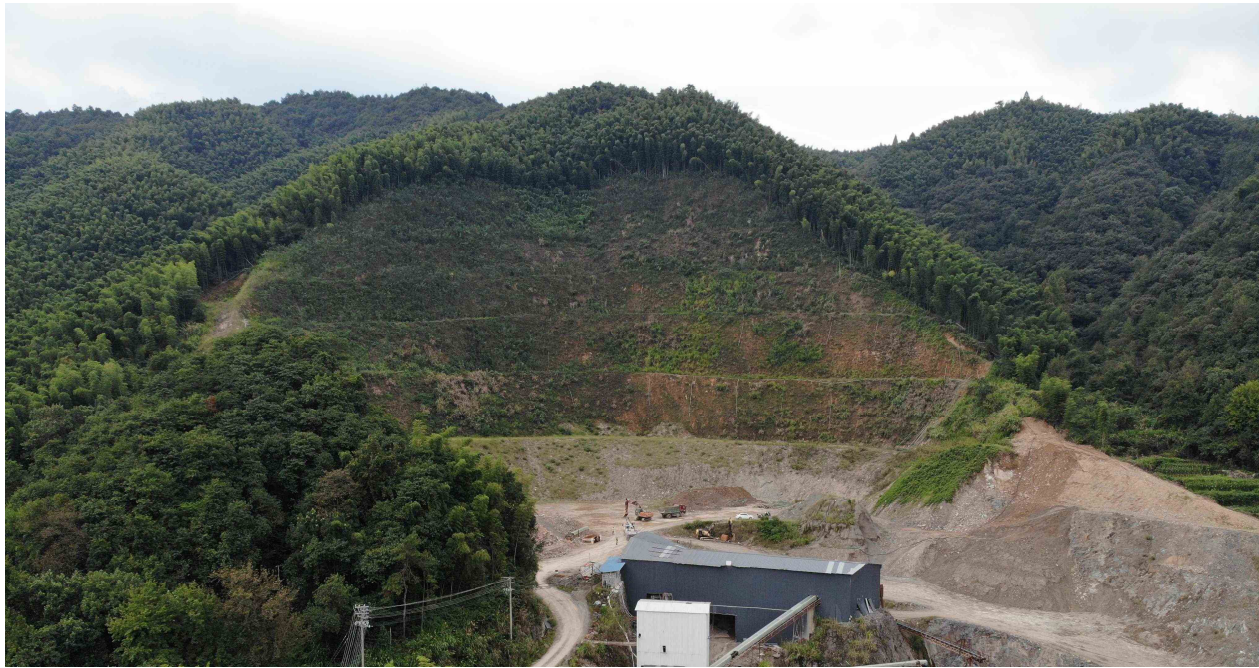
照片 2-1 主坡面治理现状
