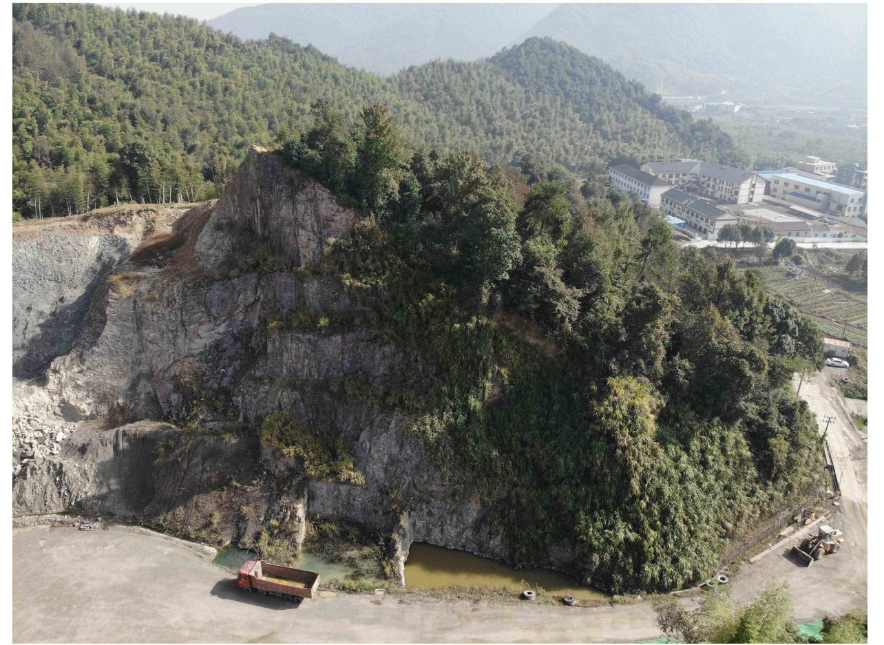
照片 2-4 CD、DE 段边坡现状
